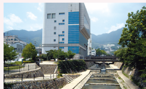
親水護岸整備(都賀川)
