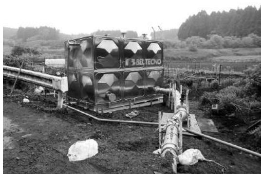
〔仮設減圧槽の設置状況〕
