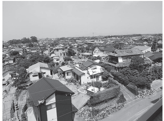
※益城町の倒壊家屋
