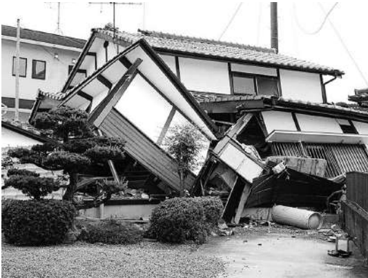
写真2 建物被害（熊本県益城町）
