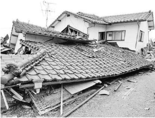
写真1 建物被害（熊本県益城町）
