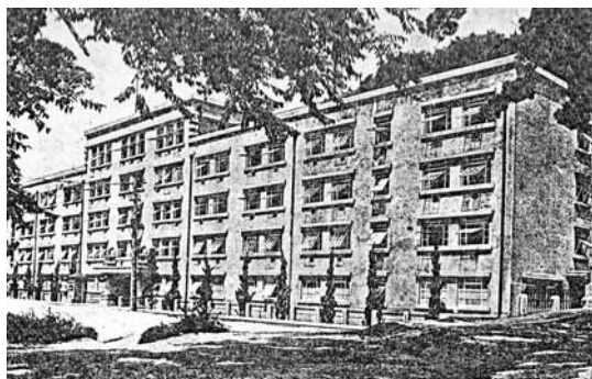
完成直後の移民収容所
