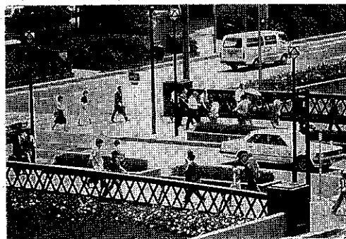
写真一5 吉田橋スクウェア計画（復元された鉄の橋） 一地下は高速道路一
