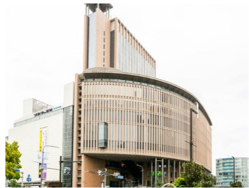
14 リージャス神戸国際会館ビジネスセンター
