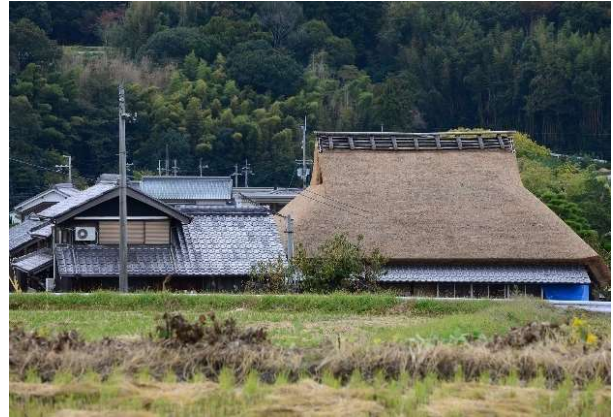
森井家住宅を北東から淡河疎水越しに見る。土手越しに茅葺屋根の主屋、瓦葺の付属棟からなる農家の佇まいをよく見ることができる。主屋の北面は下屋根がある。
