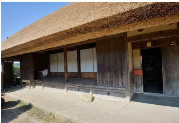
カミノマ、シモノマの縁側を見る。茅葺の軒が深く、低く垂れた素朴な農家の座敷、縁側となっている。建具も木製のものが残る。
