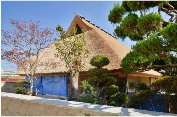
南西から茅葺屋根を見る。大きくそびえ立ち存在感のある堂々とした姿を呈している。
