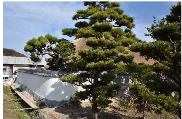
前栽と主屋を囲う塀を南西から見る。主屋、付属棟とあわせて伝統的な農家の屋敷構えを構成している。
