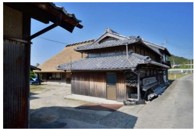
東側道路の南東側から森井家住宅を見る。道路に沿って瓦葺、土塗壁の付属棟が建ち、その奥に茅葺屋根の主屋が佇んでいる。
