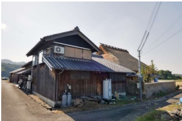
東側道路の北東側から森井家住宅を見る。二階建の付属棟北棟は比較的新しいにもかかわらず、瓦葺の屋根、杉板張りの外壁は蔵の趣を感じさせ、農家の佇まいに自然に馴染んでいる。
