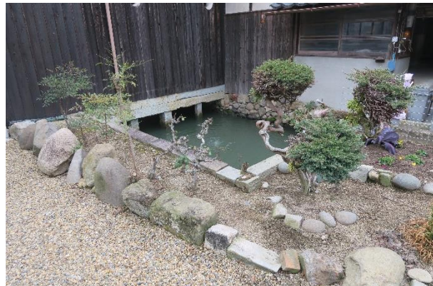
東土蔵の床下から中庭にかけて設けられている堀を敷地内部から見る。敷地外からの視認性はないが、酒造業を営んでいた痕跡として重要である。
