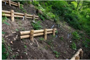
土留めの設置状況
