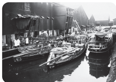
明治時代の運河ぞいの製粉工場 (神戸アーカイブ写真館)
