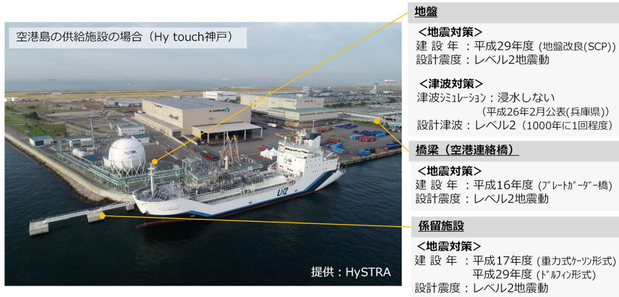
図19 水素供給施設（神戸空港島）の概要
