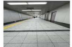
▲地下鉄ハーバーランド駅(清掃後)
