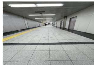
▲地下鉄ハーバーランド駅（清掃後）
