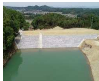
ため池改修工事
