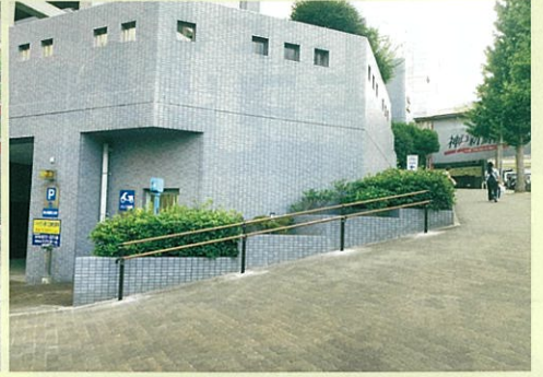
坂道での手すり設置
