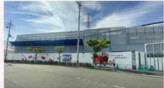
完成間近の西神南消防出張所全景
