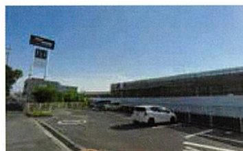
建築中のスーパービバホーム全景
