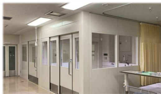
写真52 感染対策工事を行った血液透析室
