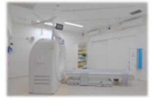
写真9 新設したCT室（西神戸）
