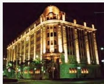
景観形成重要建築物などの ライトアップ(商船三井ビル)
