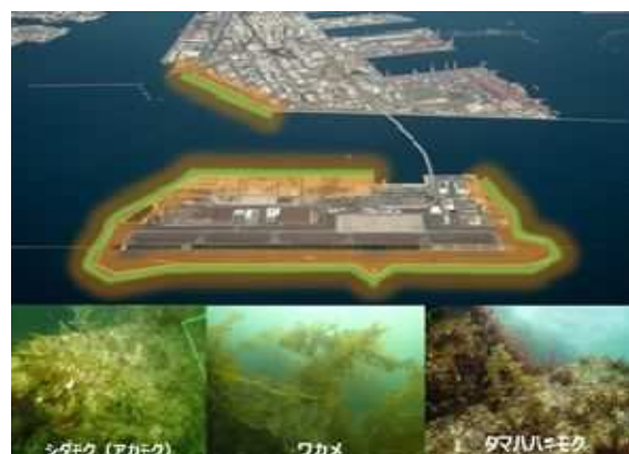
環境に配慮した護岸整備（緩傾斜護岸）
