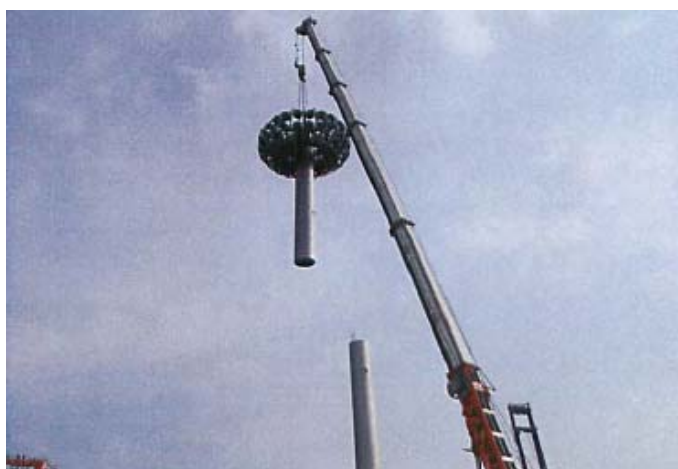
照明鉄塔再組立工事
