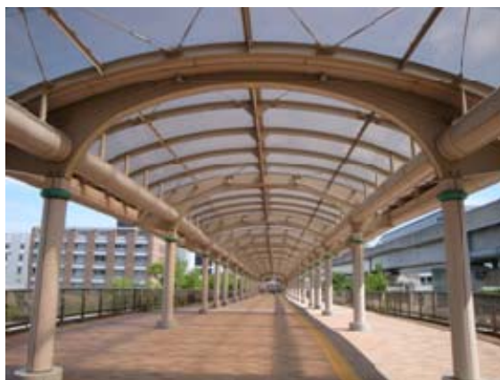
ムービングウォーク撤去後 (屋根は従来より鋼製塗装仕上げ)
