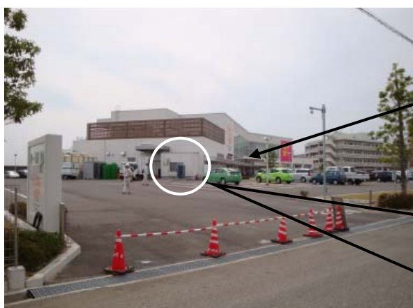
施設入口からの状況
