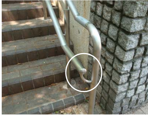
(東灘区：瀬戸公園(屋上))
