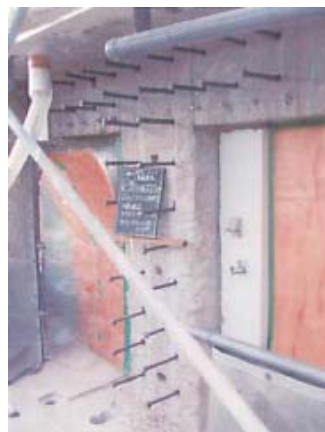
スタッドアンカー設置状況
