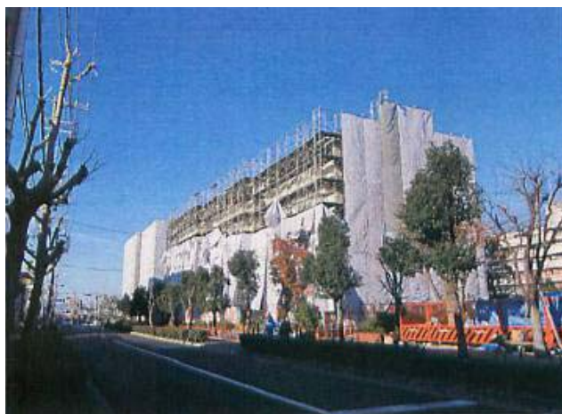
仮設工事（足場解体状況）
