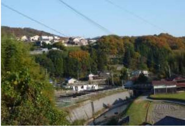
西高台から見る。 青葉台住宅地の高台の切り立った崖を背後に立地する。
