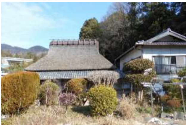
南正面から見る。平入り入母屋形式の茅葺主屋。 東（右）に付属屋が建つ典型的な農家の造りとなっている。
