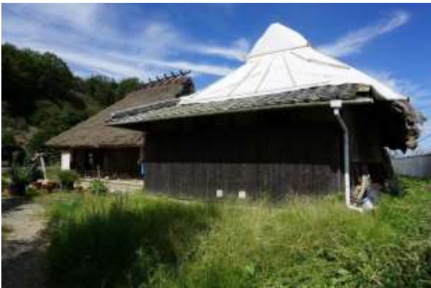
付属棟を南より見る。
