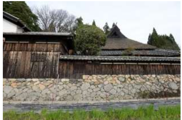
石垣は、自然石をそのまま積んだ野面積みであるが、粗さの中にも柔らかな印象を与える。
