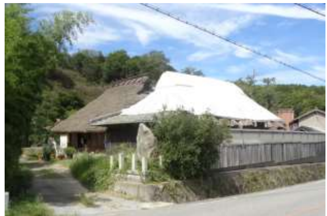
茅葺屋根の老朽化が激しい付属屋は、現在応急処置のために置千木が外されシートで覆われている。(2020年撮影)
