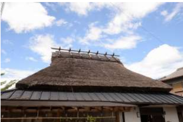
茅葺屋根の棟仕舞は、7つの置千木と竹のからすおどしで構成されている。
