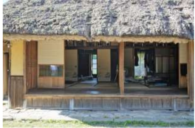
主屋縁側と外部の境界は雨戸のみで、雨戸を開放すると奥まで見通せる造りのままとっている。
