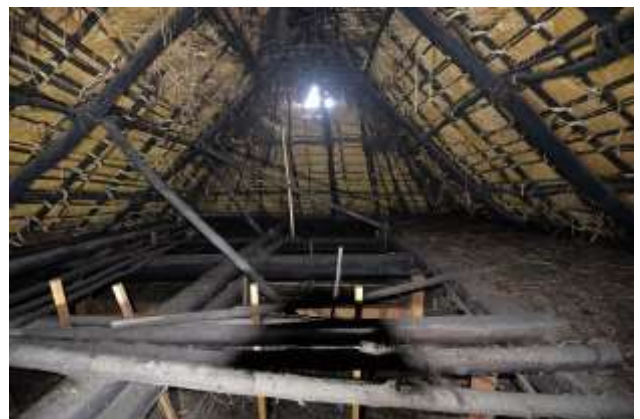
小屋裏の叉首。斜材、屋中、垂木には丸太が使われ、木舞下地は竹を使っている。
