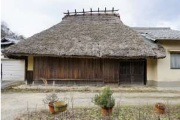
主屋を南より見る。
