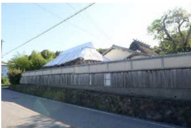
東側道路沿いの石垣の上に造られた塀は茅葺民家と一体となった屋敷構えの景観を呈し、古くからある街道沿いの風景に馴染んでいる。
