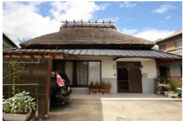
正面から見る。 平入り入母屋形式の茅葺主屋。 明治時代初期頃に建てられた四間取り農家建築であったが平成 18 年茅葺屋根を残しスケルトンリフォームした。
