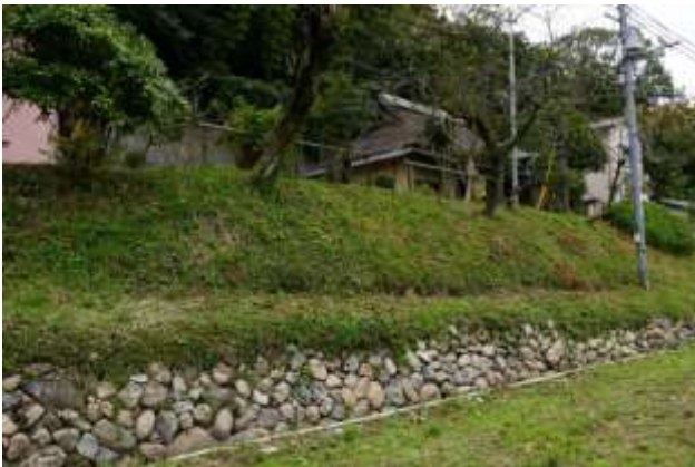
東南から見る。 石積み擁壁が、かつての丁寧な敷地造成計画の下、設置されている。
