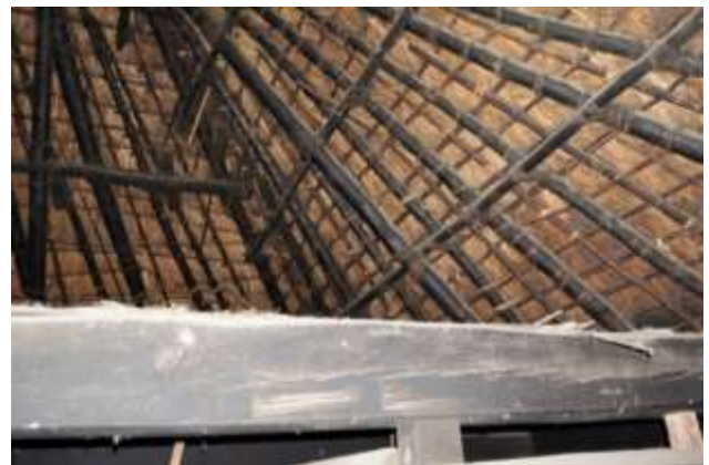
小屋裏の叉首、屋中、垂木には丸太が使われている。木舞下地は仕事が丁寧で、整然と細かく組まれている。
