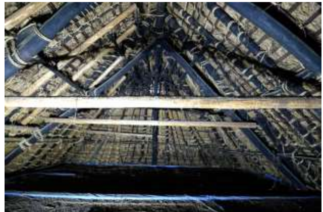
主屋の小屋組は丸太の又首組で、屋中（母屋）、垂木には丸太が使われ、竹木舞下地は細かく組まれている。
