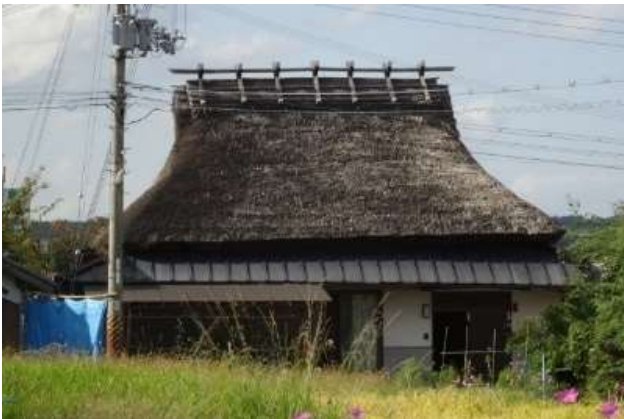
南東から望む。 茅葺屋根を残した貴重な外観。
