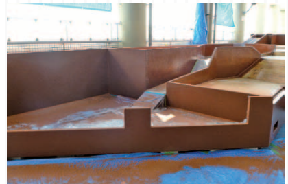
塗装の上から、カラーサンドを吹き付けます
