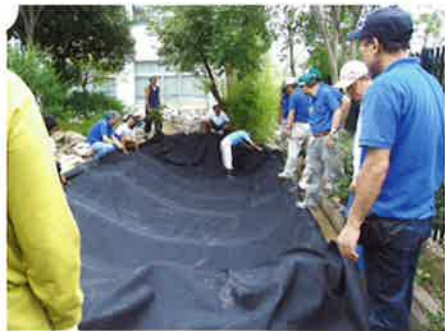
(株)三ツ星ベルトによるゴムシート張り
