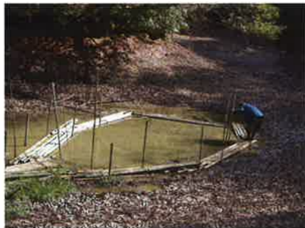
完成した足場（2月9日）
