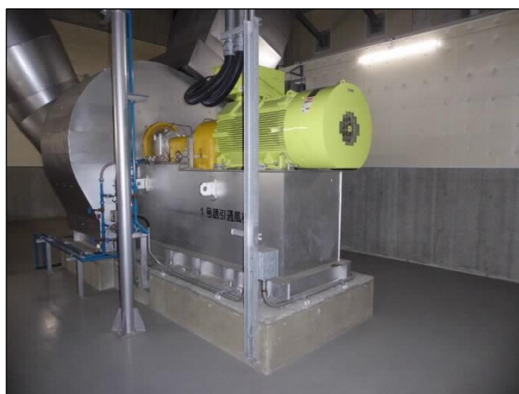
図 3-3-3 コンクリートの基礎上に機器を設置（誘引通風機）
