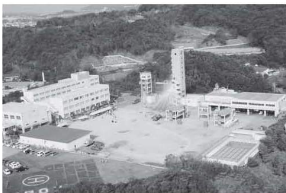
上空から見た市民防災総合センター
