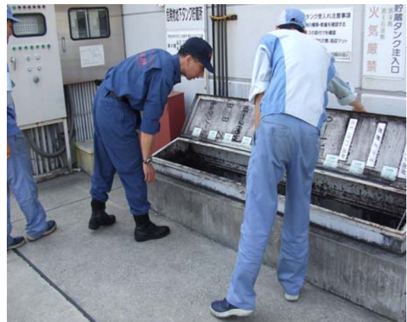
地下タンク貯蔵所の立入検査
