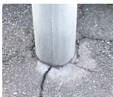
路面境界部 近接目視点検
