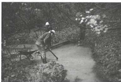
写真 6-45 小規模な溜池での堆積砂泥の搬出
