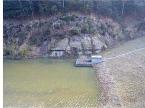
(左)調整池全景 (右)オーバーフローとなる樋
