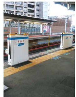
ホームドア (昇降式ホーム柵・六甲道駅)
