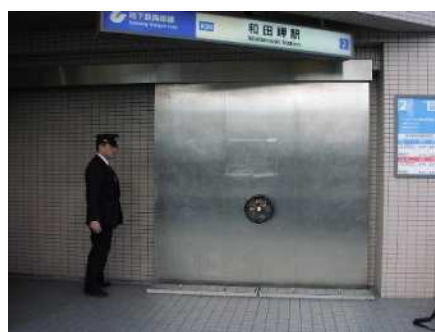
防水鉄扉の操作 (海岸線和田岬駅出入口)
