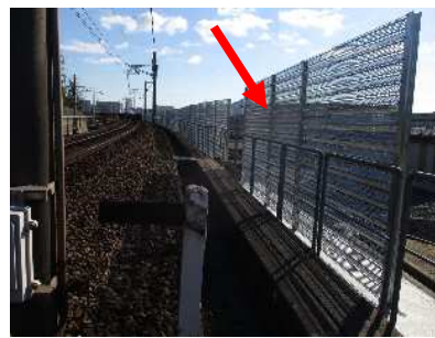
西神・山手線 盛土部分
