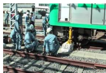
緊急対応（脱線復旧）
