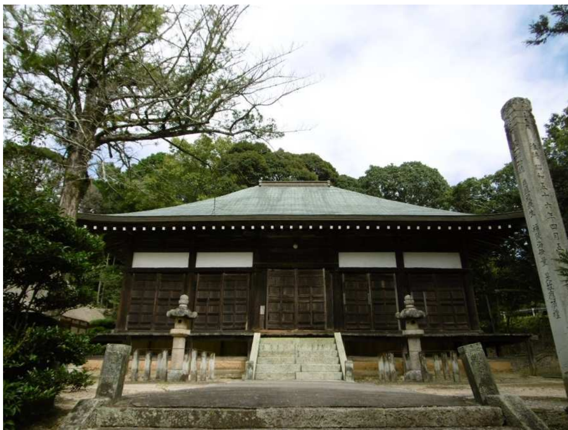
[火災前] 性海寺本堂（令和3年10月）
