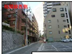
住宅中心のエリア
