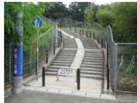
◇スロープの設置
