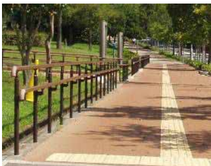
◇手すりの設置
