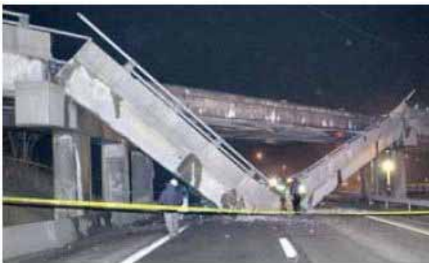
2005(平成17)年9月 米国・ペンシルバニア州でPC桁落橋（S40年架設）
