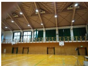
EV から避難所等への天井照明へ給電
