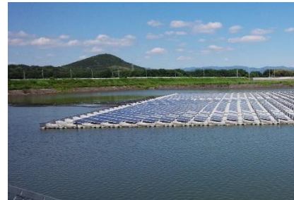
農業用ため池の太陽光発電設備
