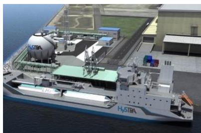
液化水素の荷揚基地
