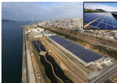
垂水処理場の太陽光発電設備
