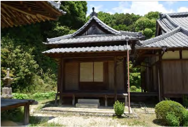
本堂（南側）屋根は入母屋
