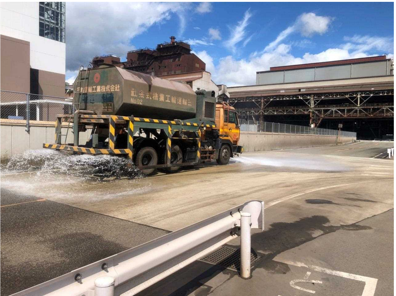
写真 4.1-1 令和4年度における車両洗浄及び道路散水の実施状況
