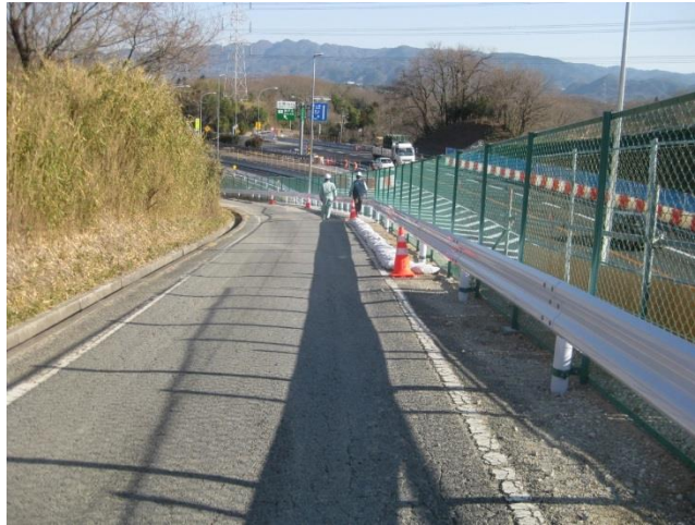
図 4-2 フェンス設置状況
