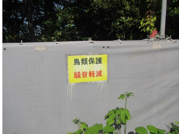
図 4-4 遮音シート設置状況
