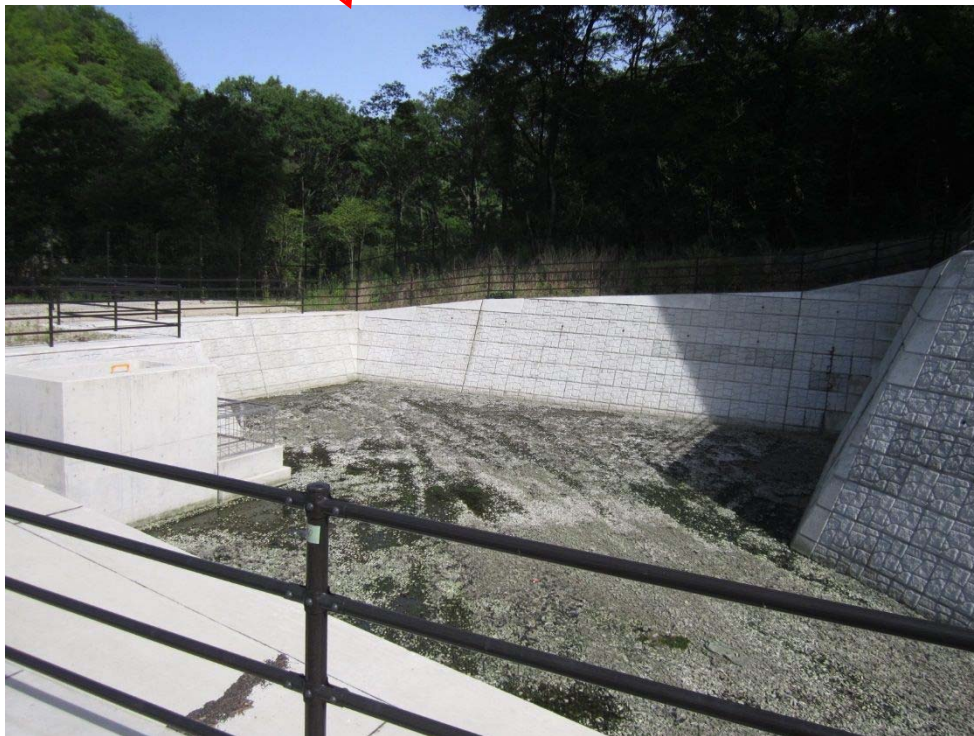
図一八 調整池設置状況（道場 TN 工事）
