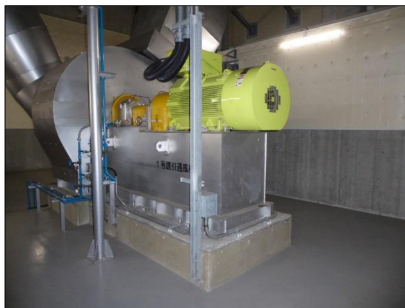
コンクリートの基礎上に機器を設置（誘引通風機）
