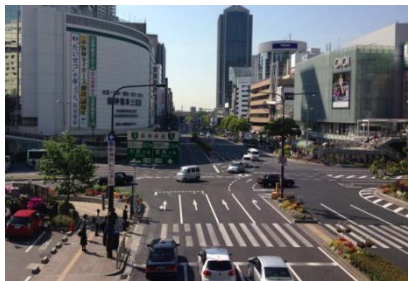
現状：車中心の道路空間
