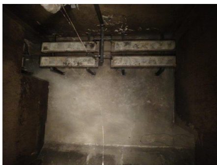
旧式の散気装置（改築更新前）
