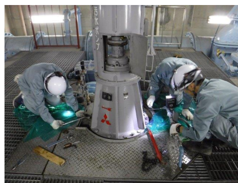
設備の補修・修繕作業
