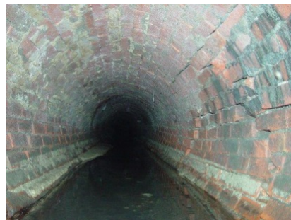
現存するレンガ水路(中央区)
