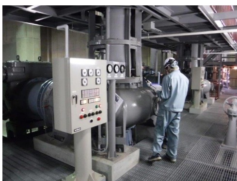
設備の点検・調査作業
