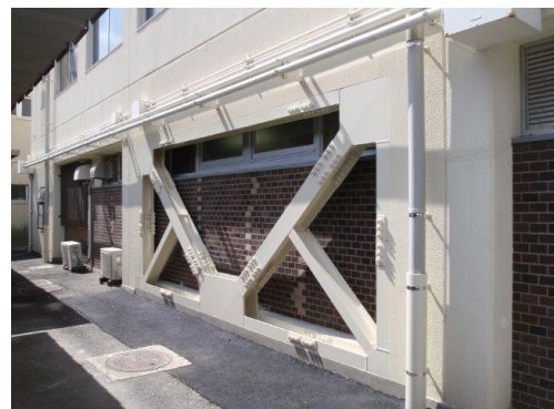
施設の耐震補強例(ブレース)
