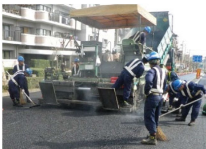
灰入りアスファルトの使用事例
